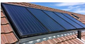
**Flachkollektor:** Diese sehr häufig eingesetzten Kollektoren eignen sich sehr gut für die Trinkwassererwärmung und Temperaturen bis ca. 80 °C. Sie lassen sich perfekt in Dächer oder Fassaden integrieren und sind im Betrieb einfach zu handhaben.
