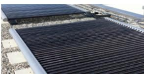
**Röhrenkollektor:** Diese Kollektorenform findet sehr unterschiedliche Einsatzgebiete. Auch bei schlechter Ausrichtung sind die Röhrenkollektoren äusserst leistungsfähig und gewisse Modelle funktionieren sogar horizontal. Dank einer Isolation ist die Leistung dieser Kollektoren auch im Winter gewährleistet.
