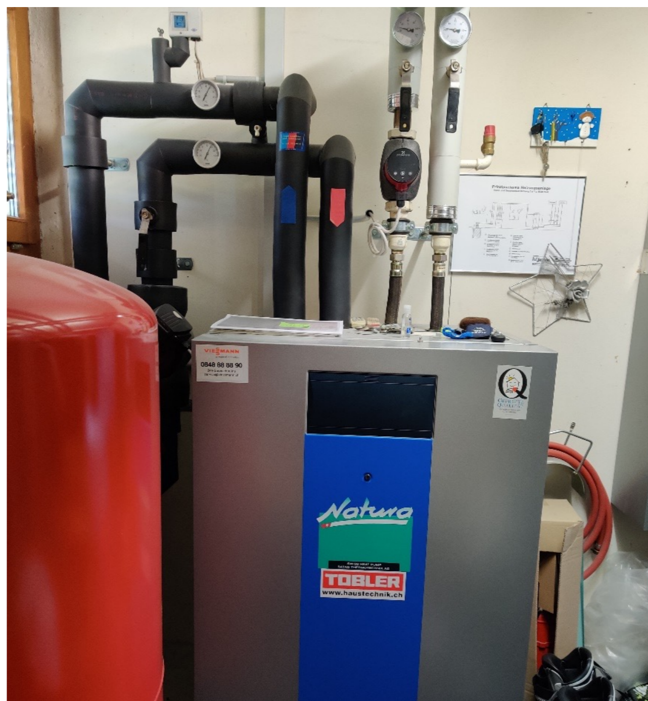
Erdwärmepumpe
